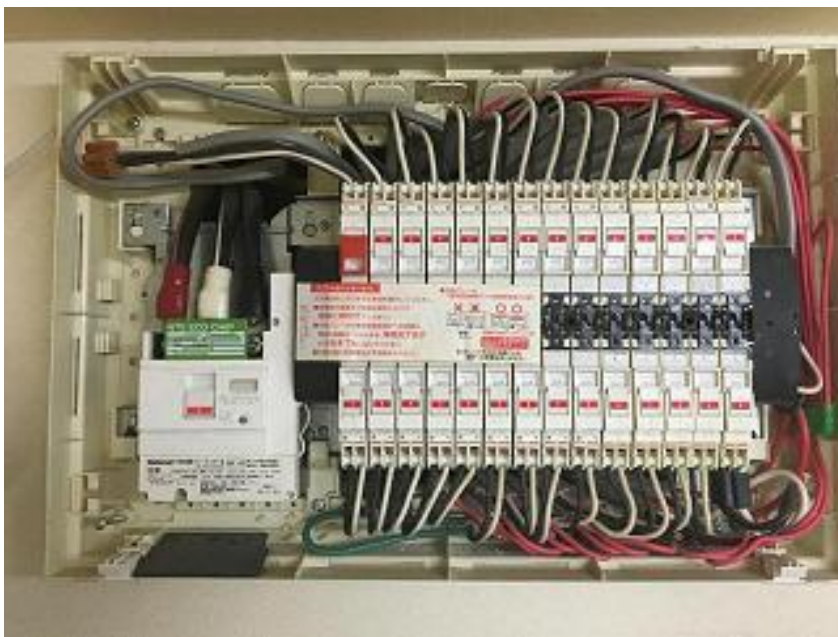
図 18 ビスがギリギリのパターン【漏電ブレーカーにシートが存在する場合】
