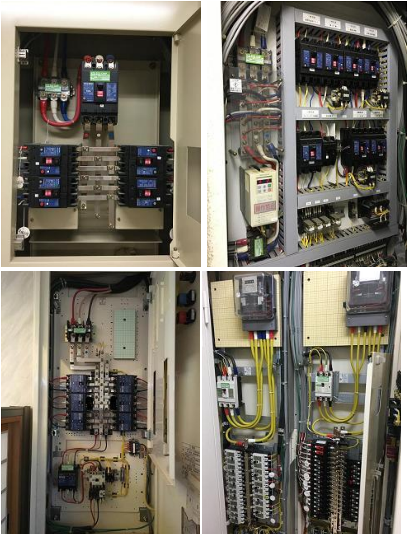
図 29 施設での低圧分電盤
