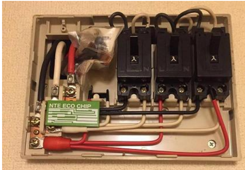
図 21 漏電ブレーカーが存在しない場合
