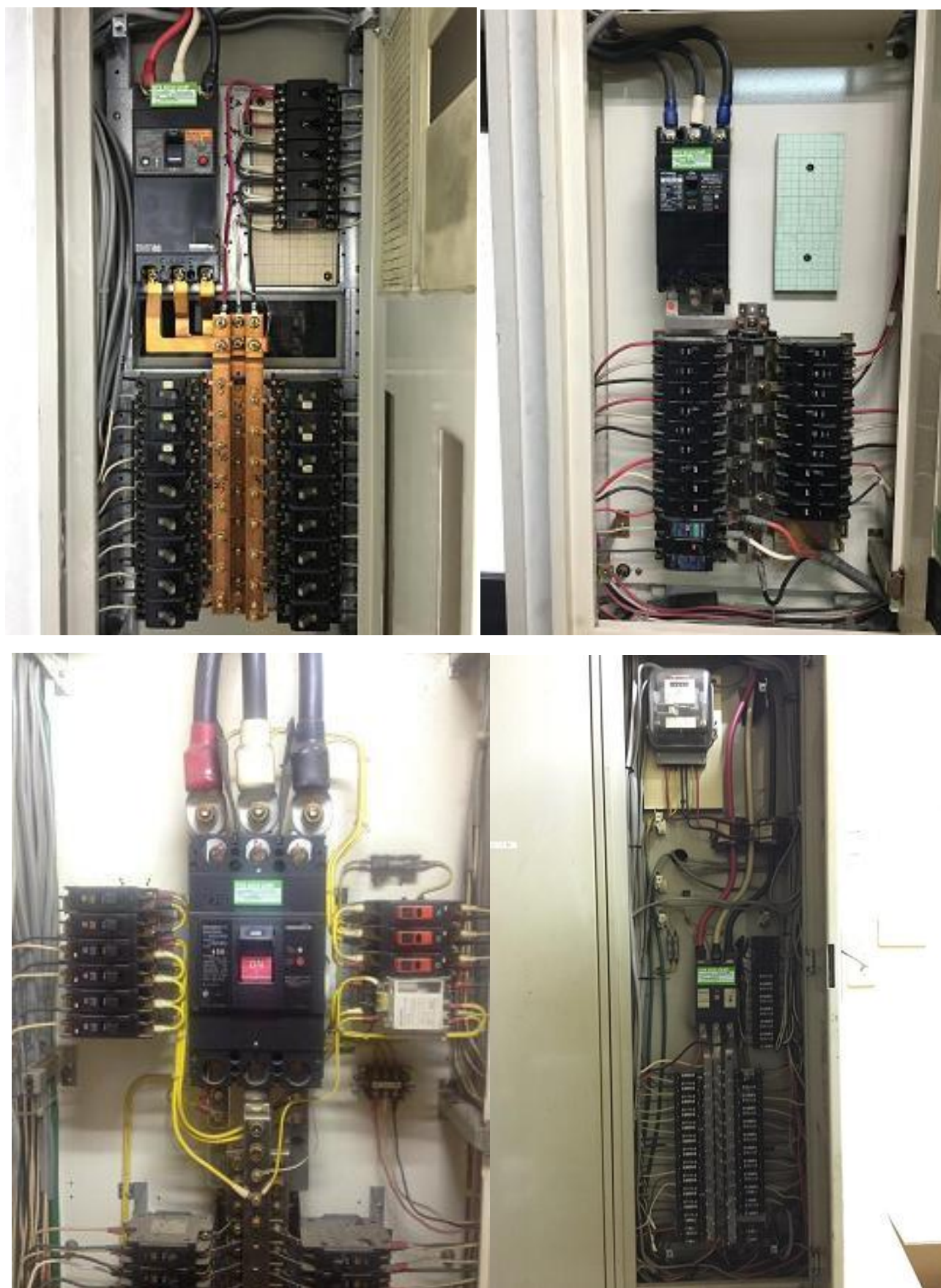
図 24 工場・店舗での従量制分電盤
