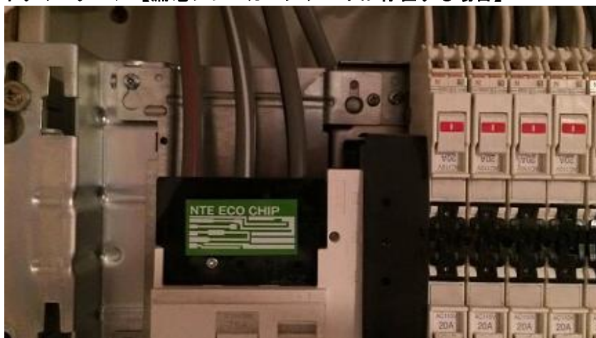
図 18 ビスがギリギリのパターン【漏電ブレーカーにシートが存在する場合】
