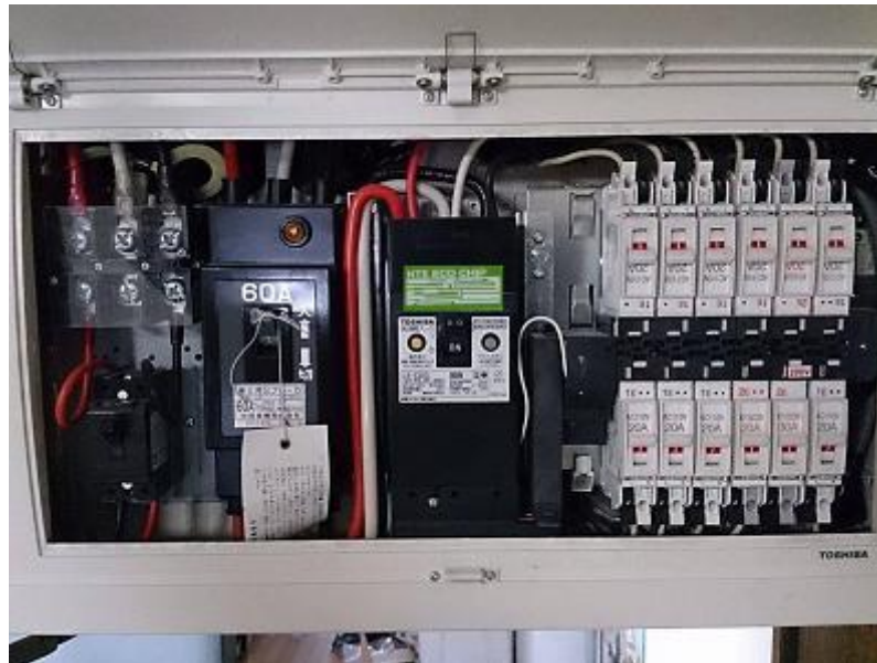
図 20 1世代前のブレーカー
