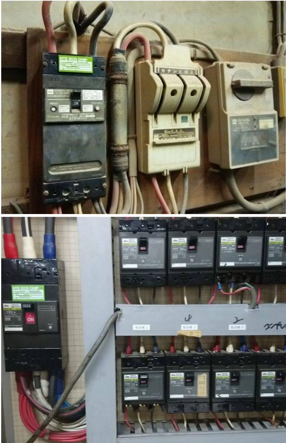
図 28 窯元・工場での低圧分電盤
