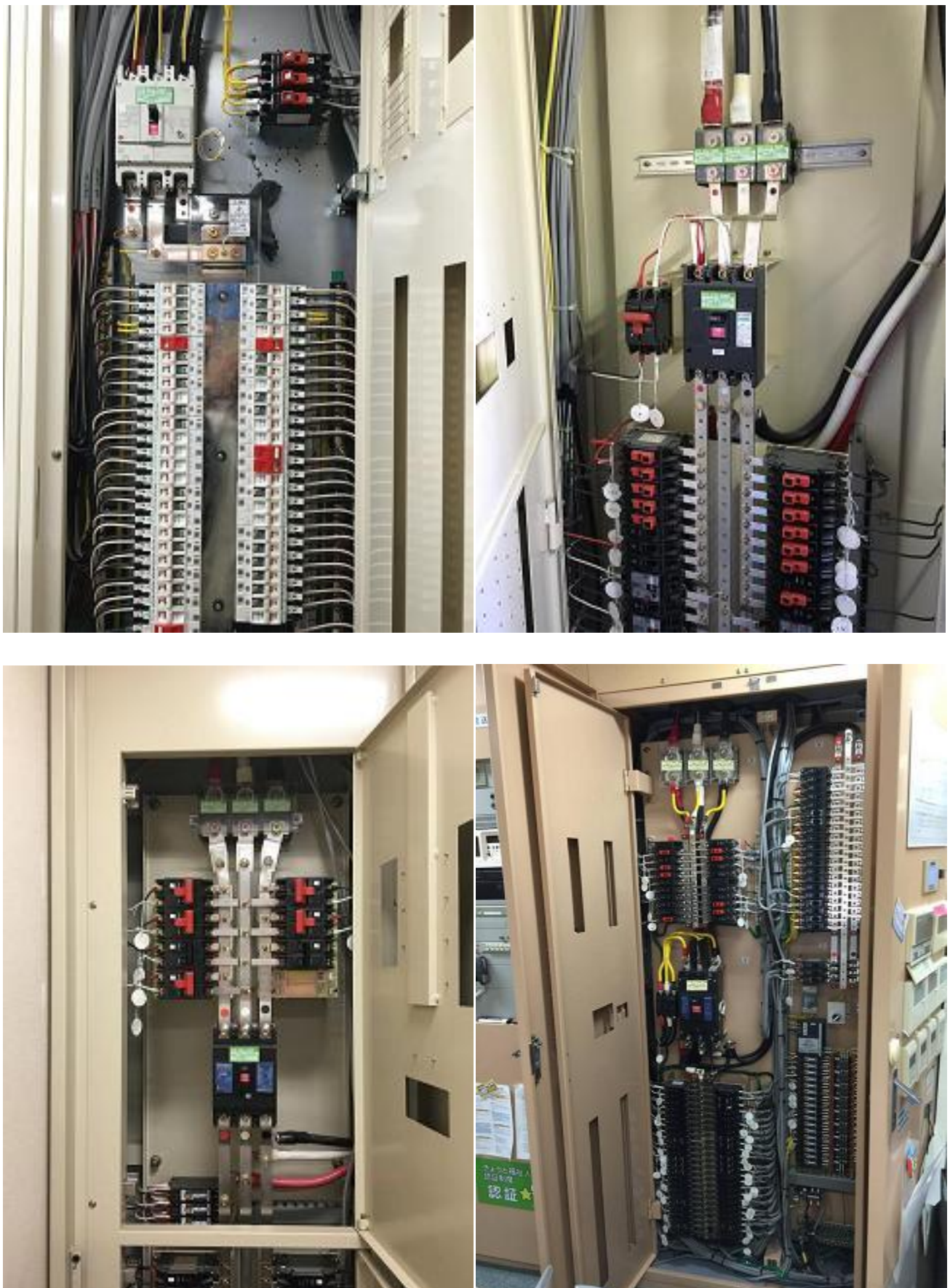
図 26 施設での従量制分電盤 2
